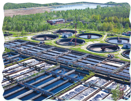
Bazine decantoare de apă
