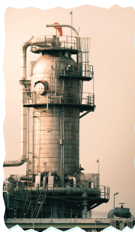
Instalație de rafinare a petrolului
