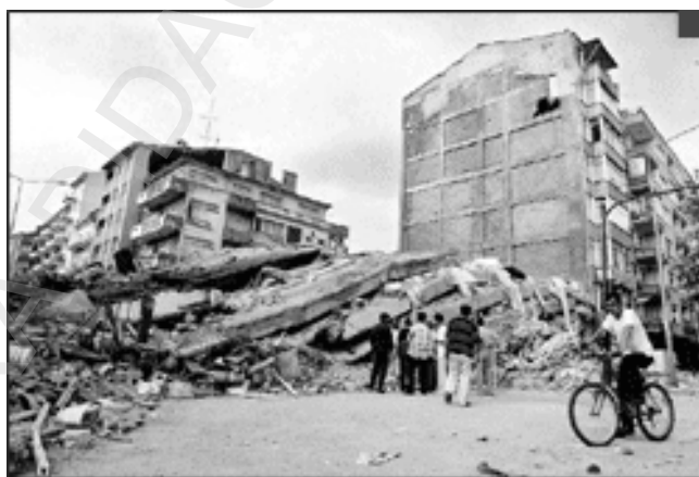
Fig. 2.42. Colapsul unei clădiri în urma unui cutremur de magnitudine 7,7 pe scara Richter
