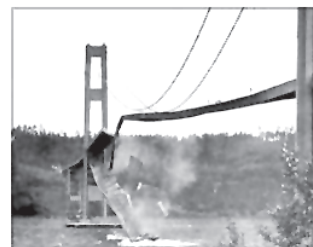
Fig. 1.2.3.4 – Prăbușirea podului Tacoma Narrows
